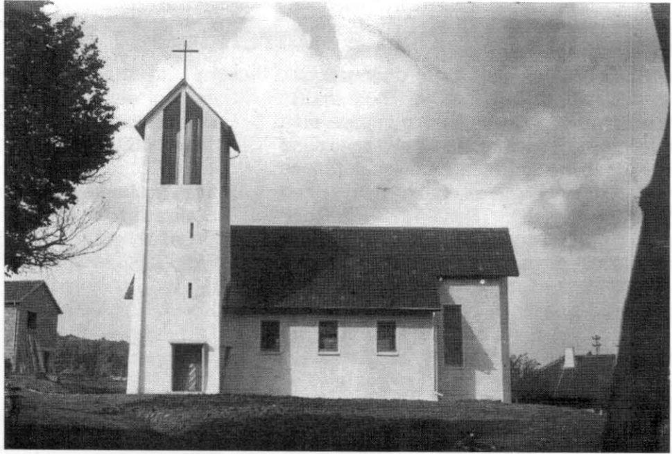
Christuskirche während der Bauphase 1955
