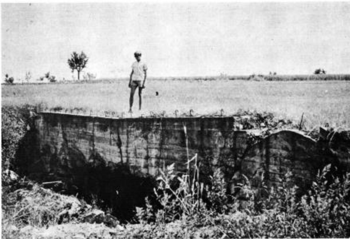
Gesprengte Bunker auf dem Lugenberg, 1964
