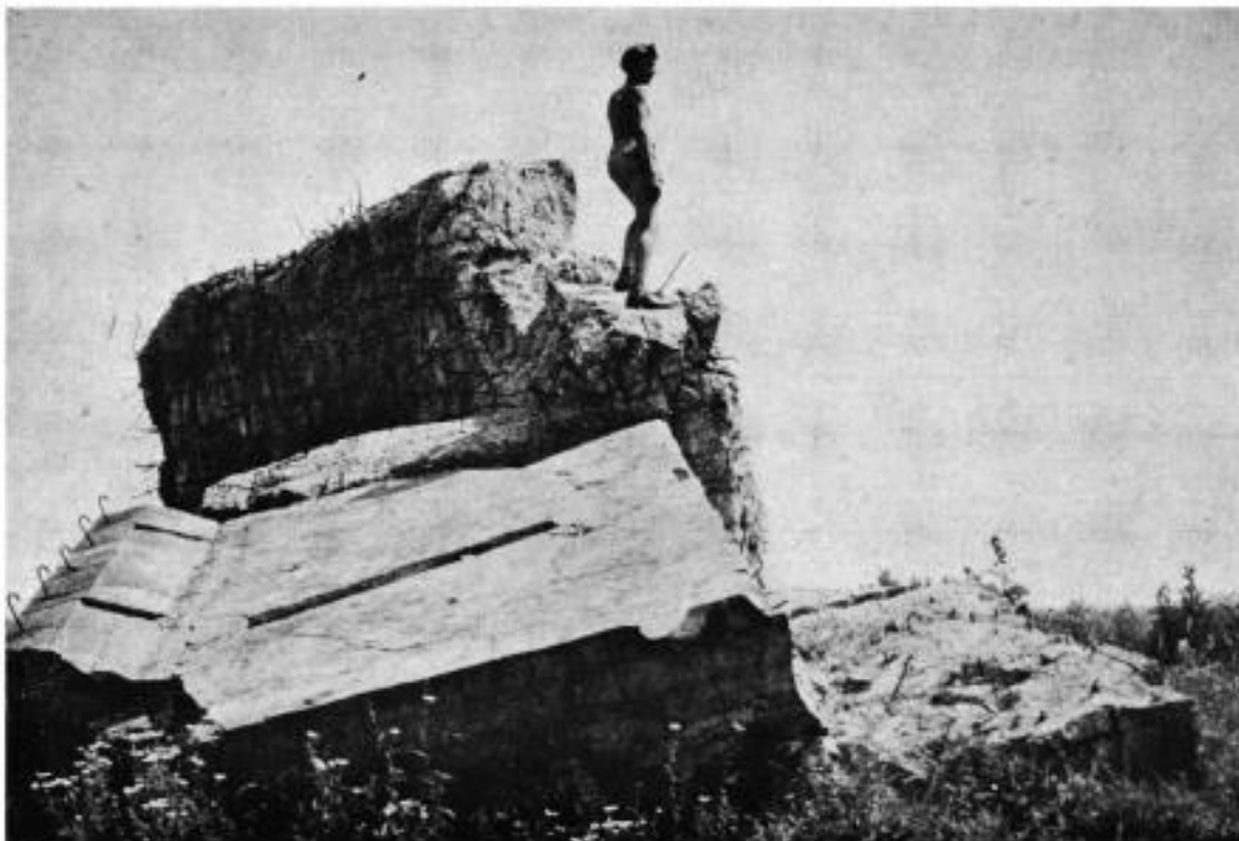
Gesprengte Bunker auf dem Lugenberg, 1964
